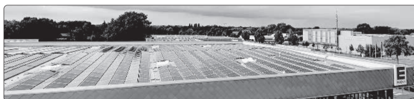
Umweltfreundliche Stromerzeugung auf den Dachflächen versorgen die Gebäude von „Aue Süd“ und speisen ins Netz ein. Foto: Axel Grell
